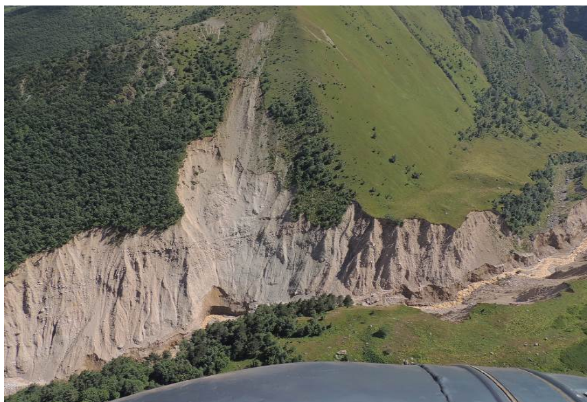
Рис. 3. – Участок входа селевого потока в верхний моренный канон с огромными запасами рыхлых селеобразующих грунтов
