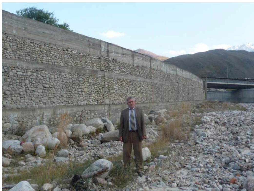
Рис. 1. – Концевой участок селепроводящего лотка (конуса-выноса), построенный авторами по своему проекту в 2001-2002 г.г. в г. Тырнаузе (Патент № 2202678).
