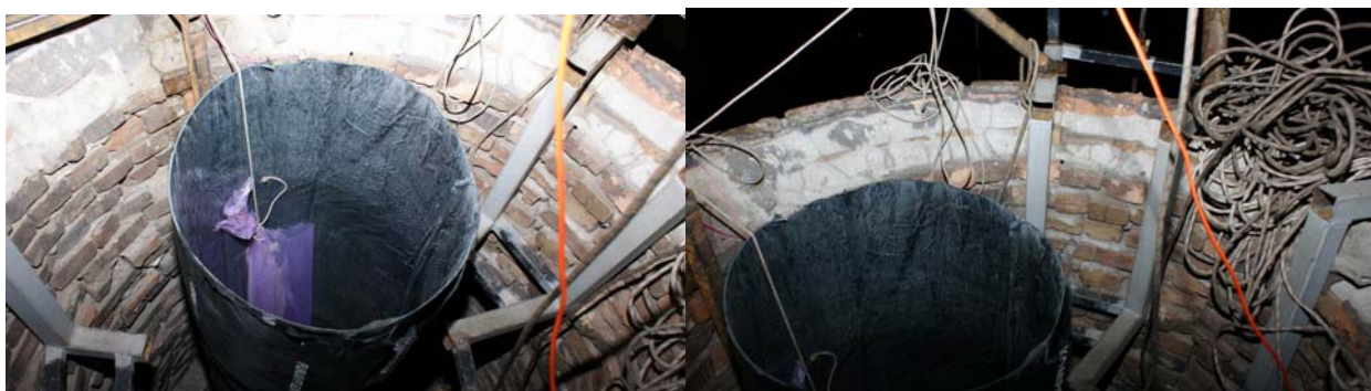
Рис.10 Оголовок трубы . Изображена верхняя часть трубы Фуранфлекс после монтажа.
