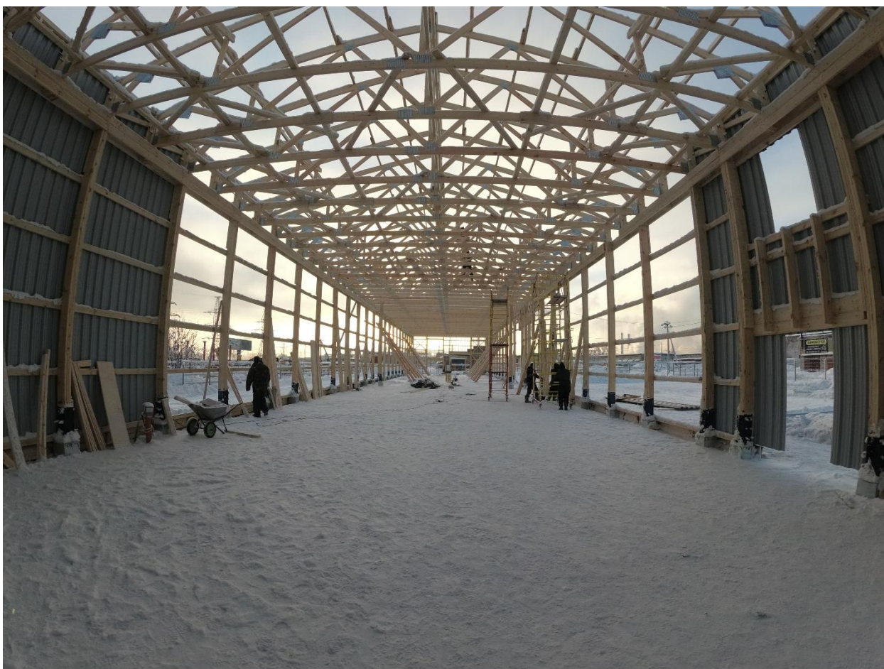
Рис. 6. – Ангар в процессе строительства
