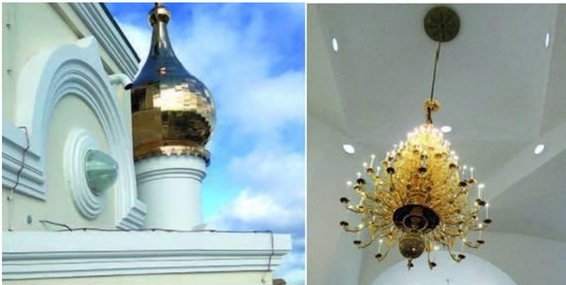
Рис.3. Светособирающий купол и световодная подсветка главного свода храма [13]
