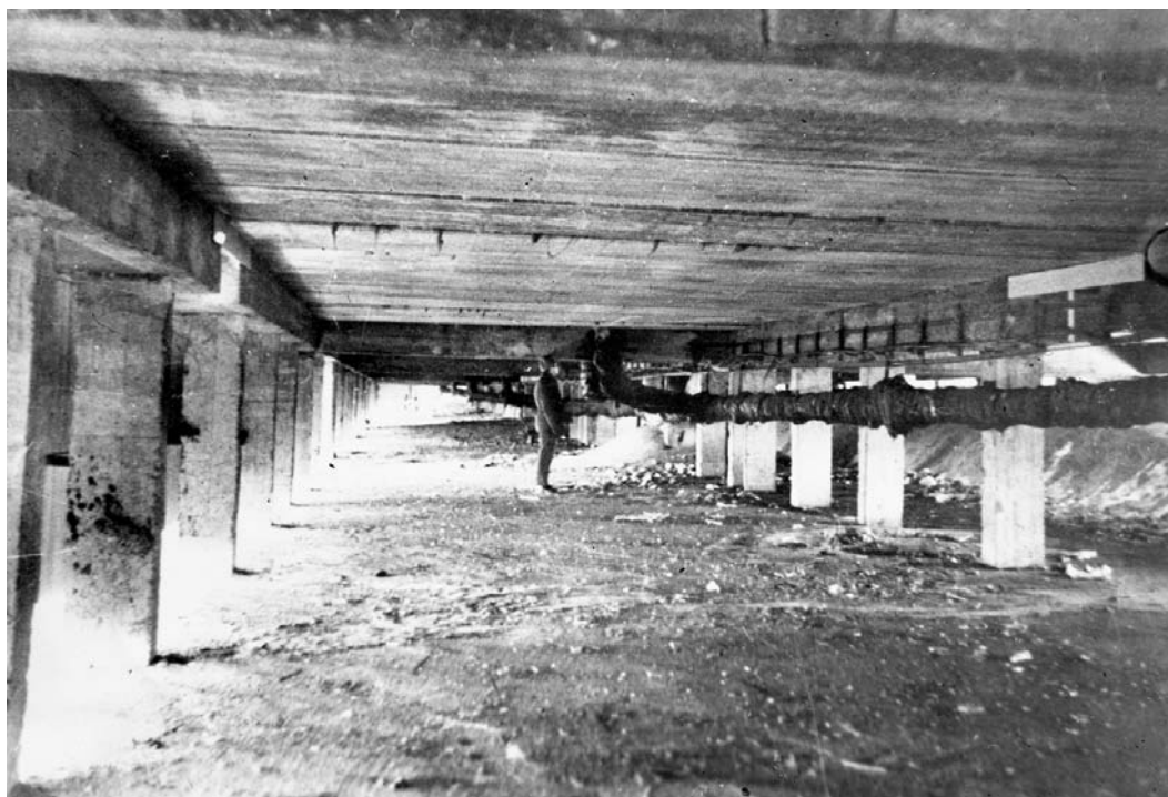
Рис. 1. - Проветриваемое подполье в жилом доме
