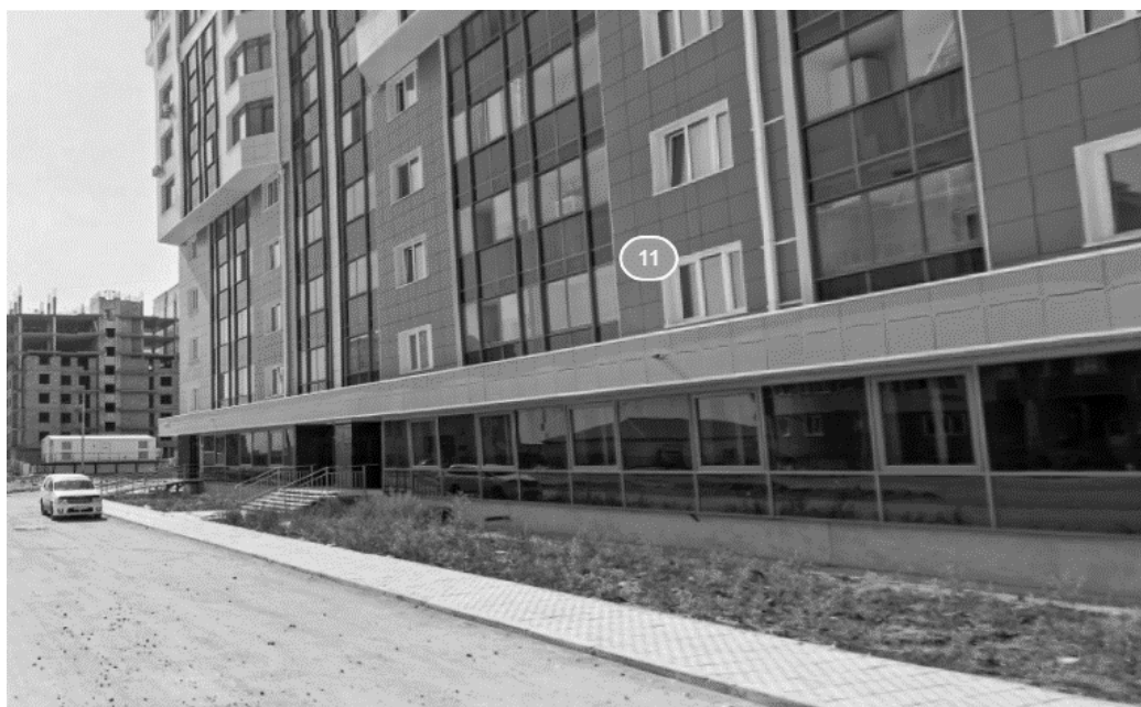
Рис. 3. - Жилой дом на намывных грунтах без вентилируемого подполья в Якутске в 203 мкр-не.
