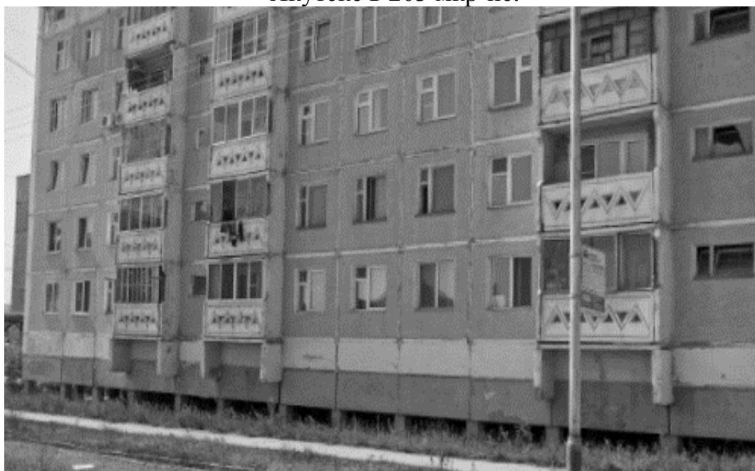
Рис. 3. - Жилой дом на намывных грунтах с вентилируемым подпольем в Якутске в 202 мкр-не.
