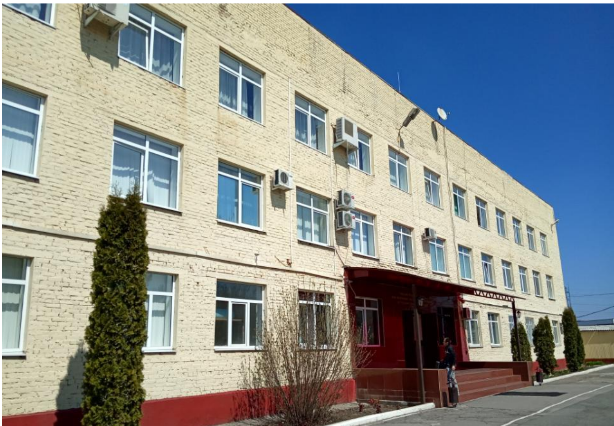
Рис.2 – Общий вид реконструируемого здания
