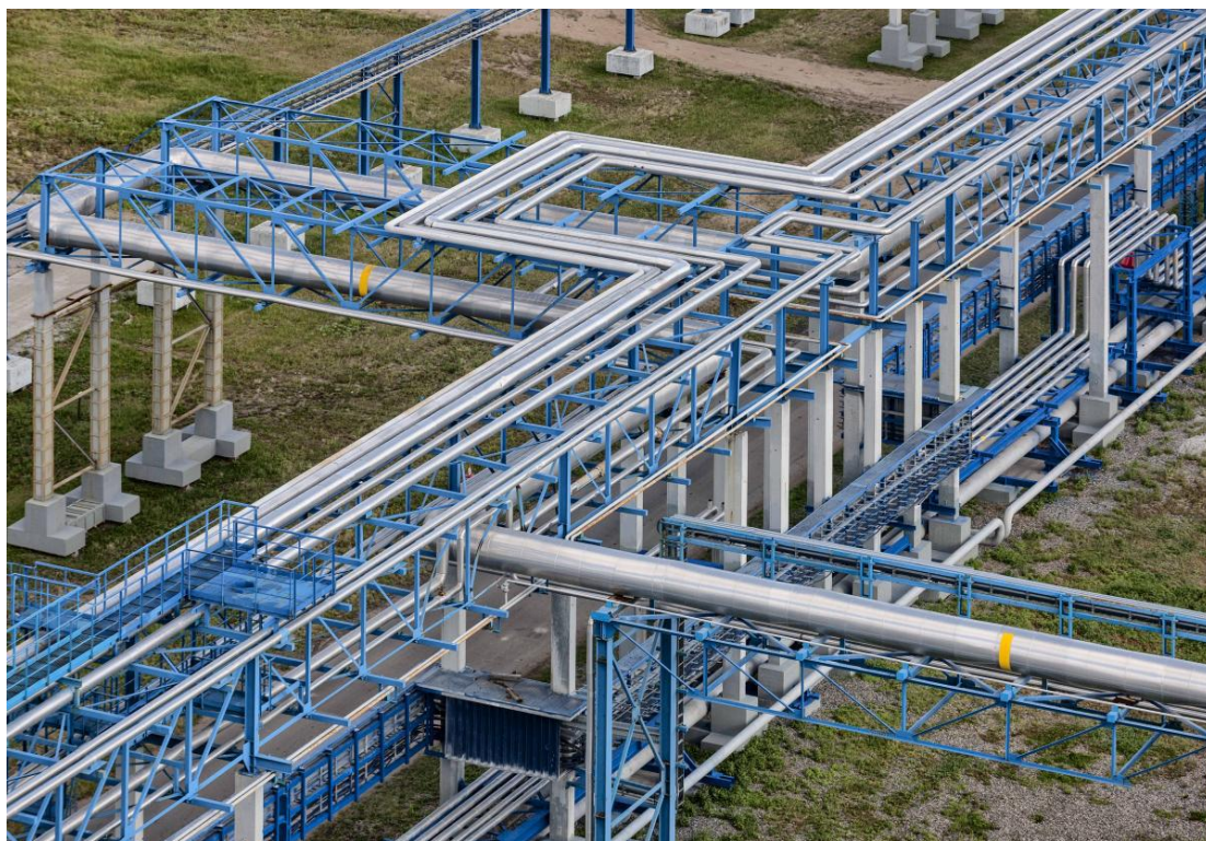
Рис.1. Участок эстакады под трубопроводы, строящейся АГХК
