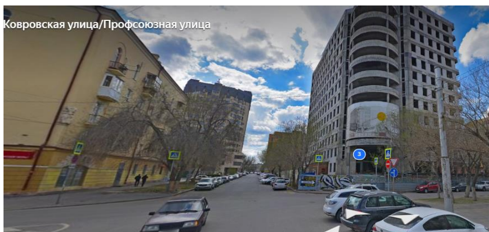
Рис. 2. Незавершенное строительство здания бизнес-центра в г. Волгоград
