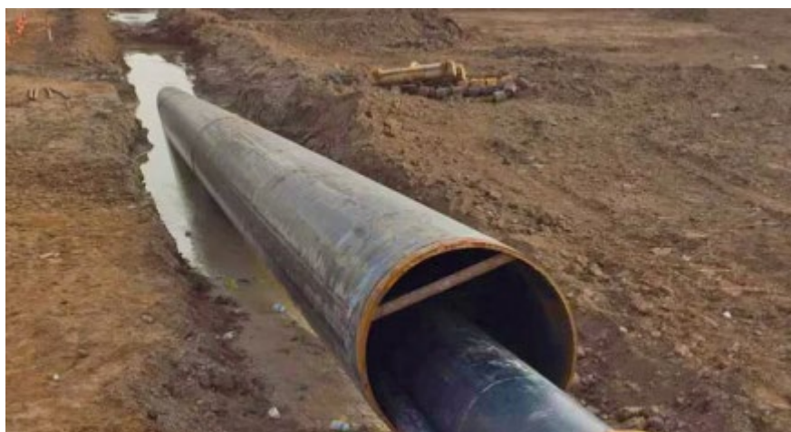
Рисунок 3. Метод строительства трубопровода «труба в трубе» [5]
