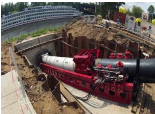
Рисунок 2. Метод строительства переходов трубопроводов «микротоннелирования» [4]
