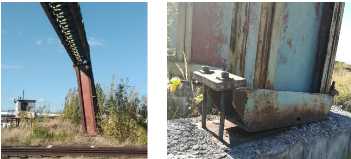
Рис.1. Вид эстакады после столкновения
