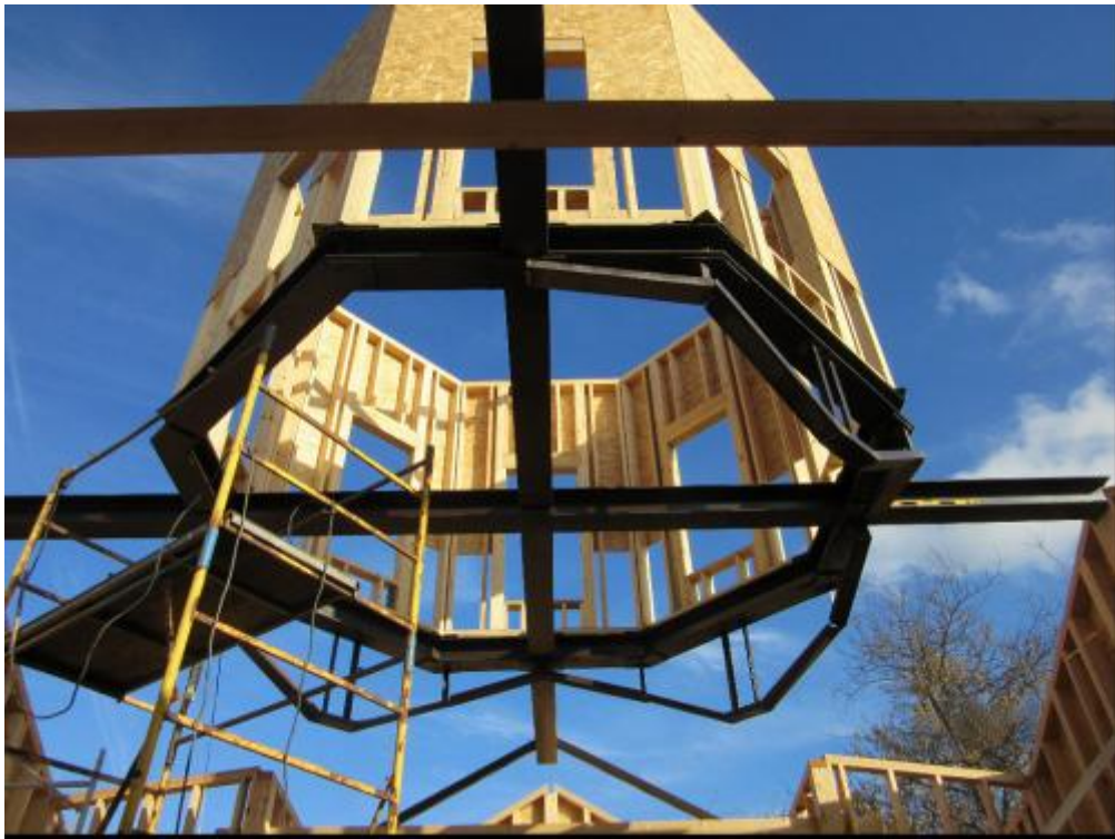
Рис. 2. – Стальная опорная конструкция восьмигранника
