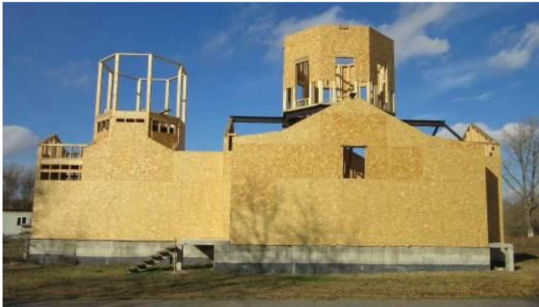
Рис. 4. – Храм в процессе строительства
