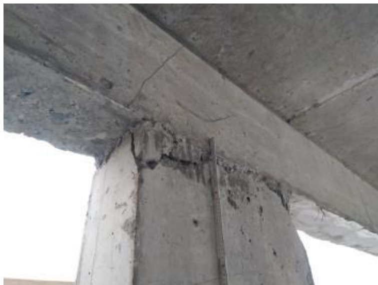
Рис. 9. – Отколы бетона
