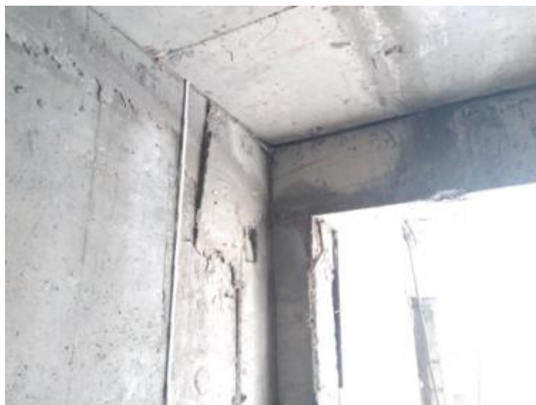
Рис. 8. – Наплыв бетона
