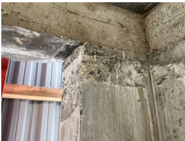
Рис. 4. – Неоднородность бетона
