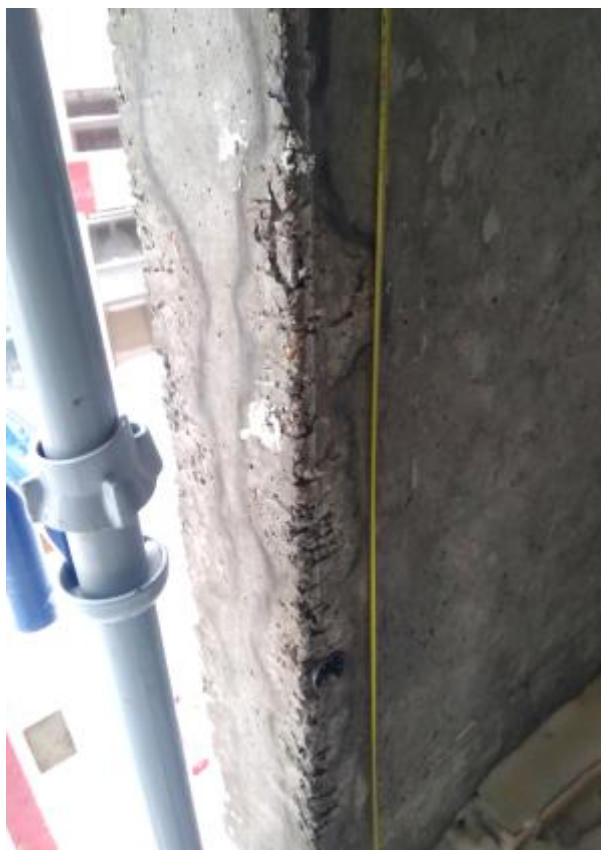
Рис. 5. – Щебенистость бетона
