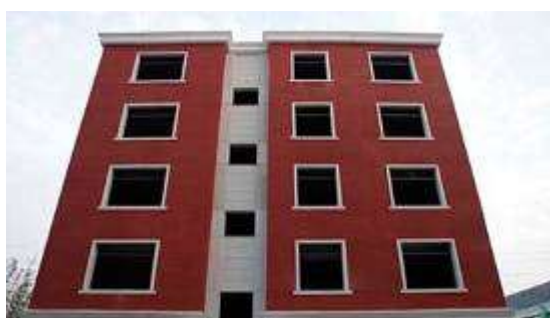
Рис. 2: Дом построенный компанией ShanghaiWinsun по технологии 3D печати.
