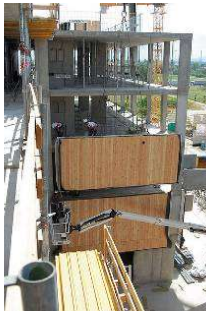
Рис. 14. Монтаж деревянных панелей наружных стен на железобетонный каркас здания в Вене комплекс зданий D12 в новом Seestadt Aspern [12].
