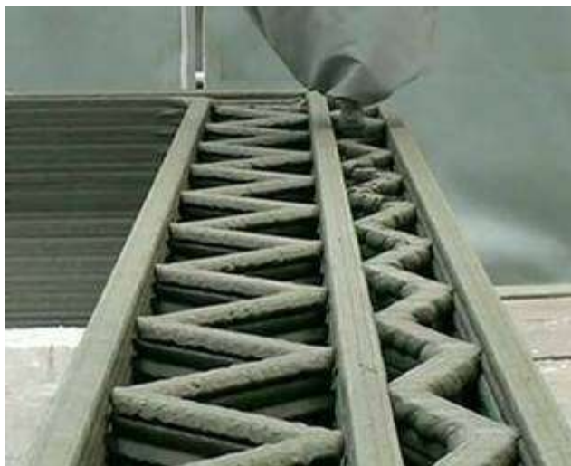
Рис. 1: наружная стена в процессе 3D печати.
