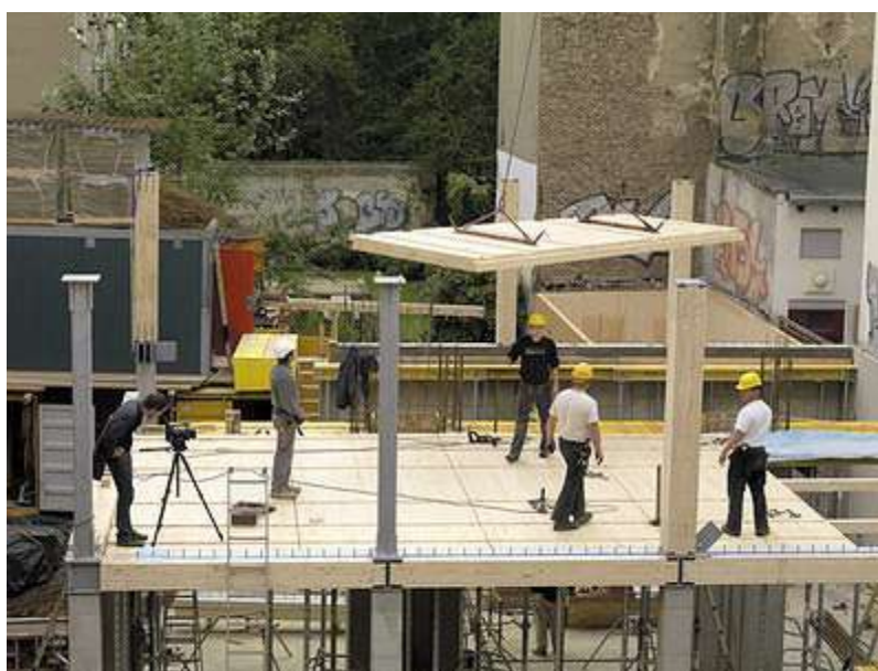
Рис. 10: Монтаж массивных деревянных панелей перекрытия на металлическую конструкцию при строительстве здания в Берлине [12].
