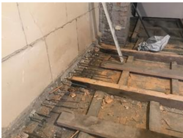
Рис.2. - Устройство железобетонного диска перекрытия взамен деревянного (авторская разработка)
