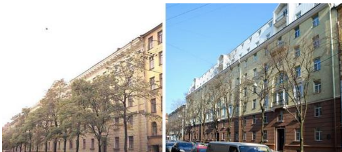
Рис.7. - Г. Санкт-Петербург, Общежитие академии им. Можайского (фото до реконструкции [12], фото после реконструкции [13])
