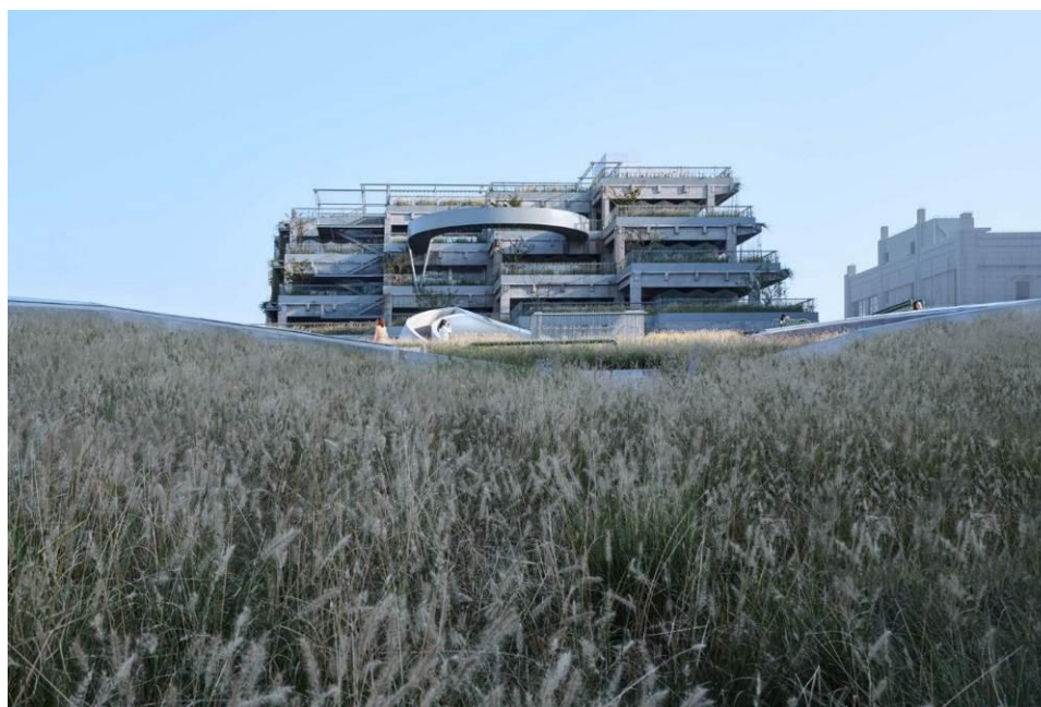
Рис. 6. – Зеленая кровля на крыше бывшего табачного склада возле Ферри-Нингуо-Роуд в Шанхае, Китай [9]
