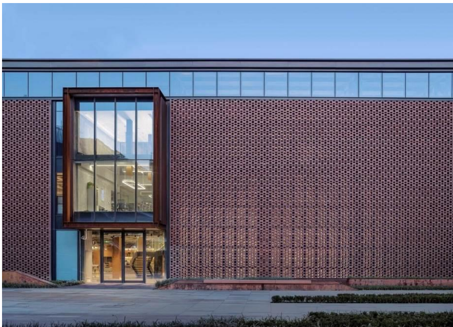
Рис. 2 – Использование металлических панелей и кирпича на фасаде здания металлического завода после реновации, Шенжень, Китай [3]
