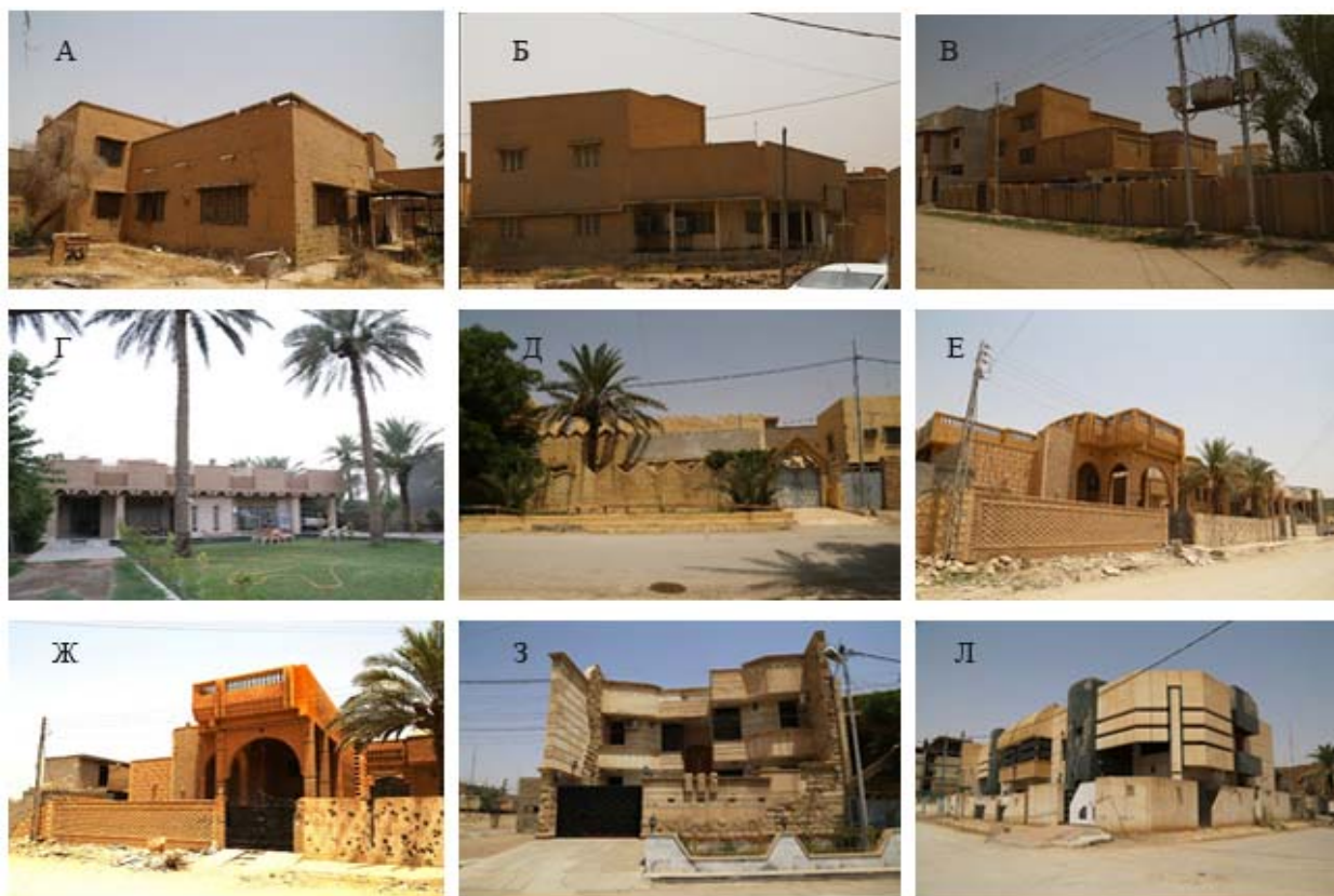
Рис. 5. – «А» дом построен в городе Эр-Рамади в 1962г.; «Б» дом построен в городе Эл-Фаллудже в 1972г.; «В» дом построен в городе Эль-Фаллудже в 1979г. Дома «А, Б, В» построены с конструкциями металлическим двутавром с кирпичами. Рис. «Г» дом в городе Эр-Рамади, построен в 1982 г.; «Д» - дом в городе Эр-Рамади, построен в 1989г.; «Е» дом построен в городе Эр-Рамади в 1993г.; «Ж» дом построен в городе Эль-Фаллудже в 1999г.; «З» дом построен в городе Эр-Рамади в 2004 г.; «Л» дом в городе Эр-Рамади, построен в 2012-2013гг. Дома «Г, Д, Е, Ж, З, Л» построены монолитными железобетонными конструкциями.
